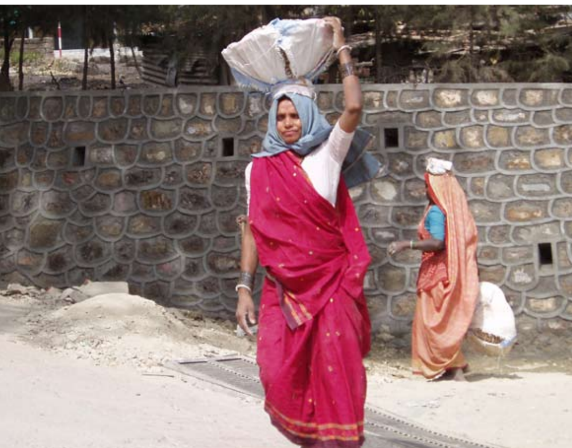
Zasuwiają po kilkadziesiąt metrów taszcząc na głowie gruz i ciężkie materiały budowlane
